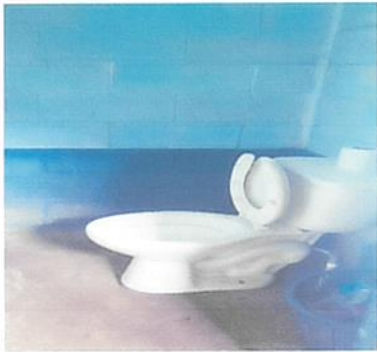
Foto 3: Instalación de baños.
