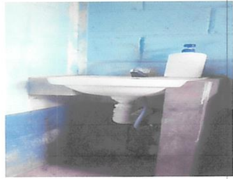
Foto 4: Instalación de lavamanos.
