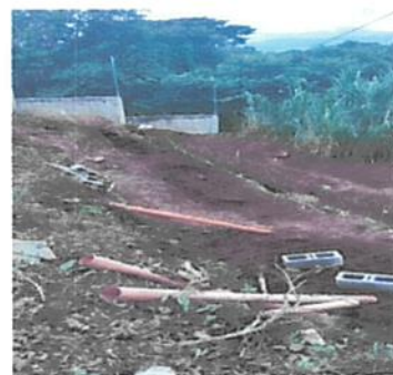
Foto 6: Construcción muro de contención.
