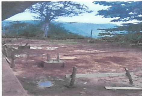
Foto 5: Construcción de galera.
